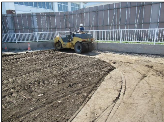
ローラーによる転圧工
