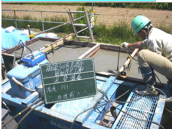
発生濁水（処理前） 濁度:825ppm
