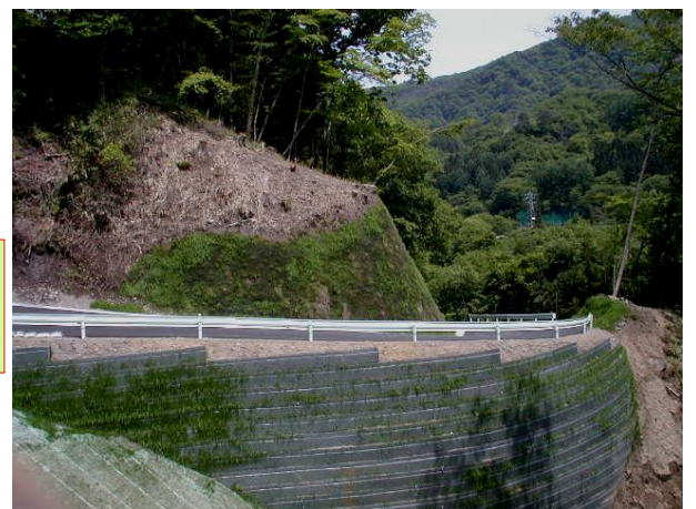
施工後 2ヶ月後
