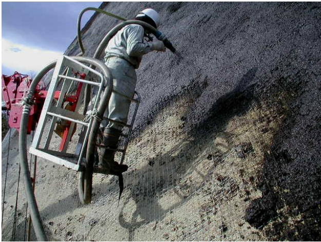
高所作業車を用いた施工状況
