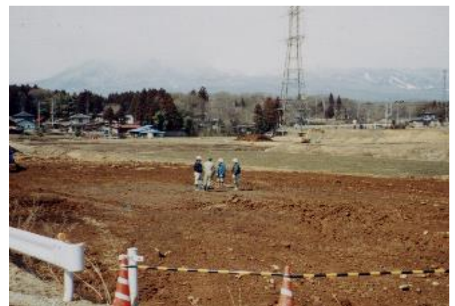
トラクター混合後、キャリアダンプにて締め転圧
