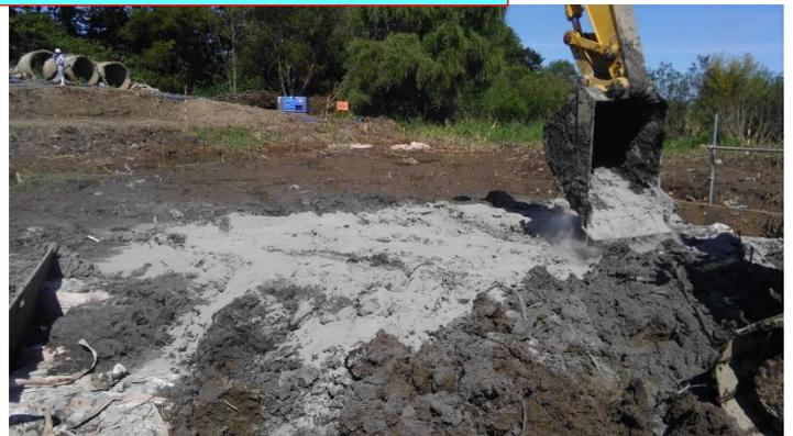
0.7 m<sup>3</sup>クラスのバックホーにて作業を進める。改良直後にバックホーが乗れるので作業の進行が早い。
