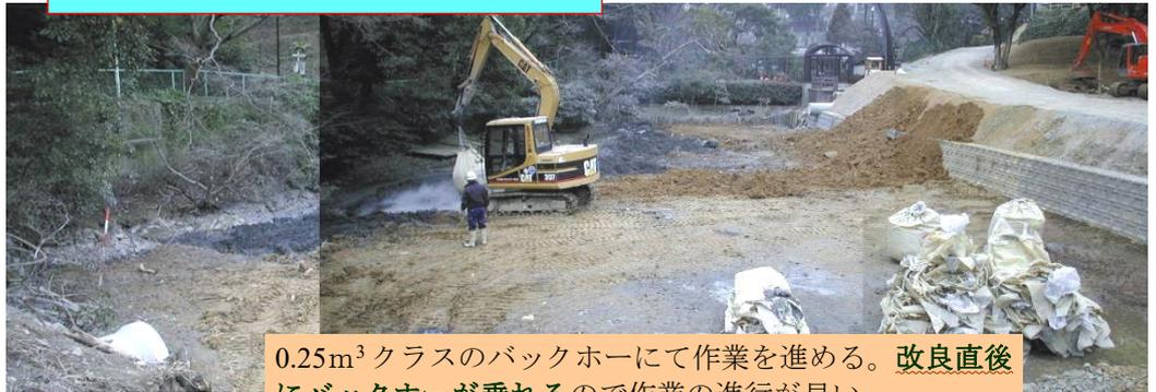
0.25m<sup>3</sup>クラスのバックホーにて作業を進める。**改良直後にバックホーが乗れる**ので作業の進行が早い。
