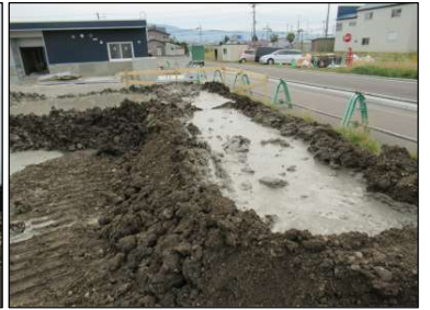
杭汚泥を釜場に集積
