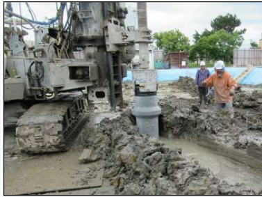
杭汚泥発生状況
