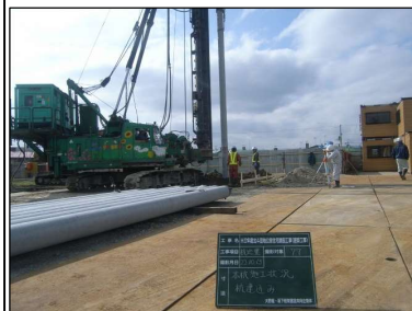
杭施工(杭建込)
