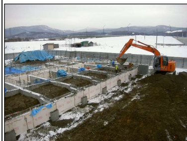
改良土埋戻し(再生利用)
