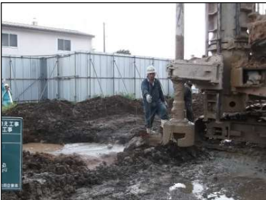
杭汚泥発生状況
