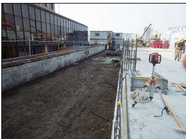
埋戻し完了（再生利用完了）
