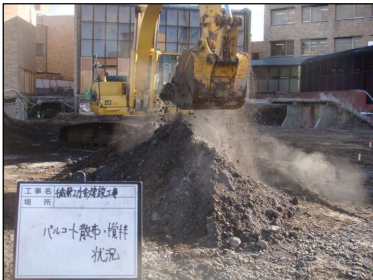
パルコート攪拌状況
