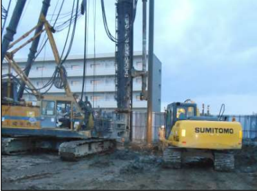
杭打ち工事状況
