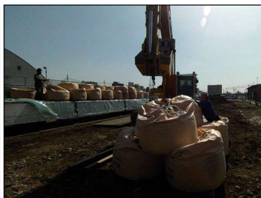
パルコート搬入状況
