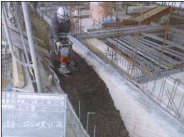
建物周辺へ埋戻（再生利用）
