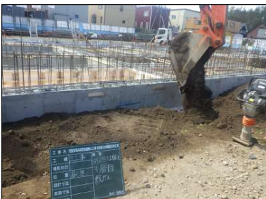
建物周辺へ埋戻（再生利用）
