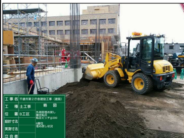
建物周辺へ埋戻（再生利用）
