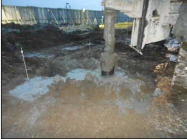
杭汚泥発生状況
