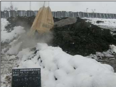
パルコート攪拌状況
