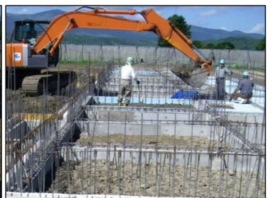
改良土埋戻し状況
