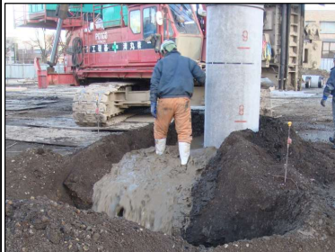
杭汚泥発生状況
