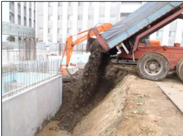
建物周辺へ埋戻（再生利用）
