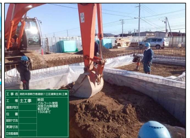
建物内へ埋戻し(再生利用)
