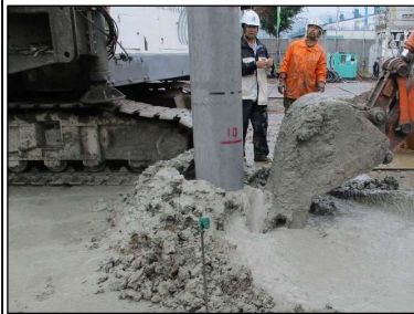
杭汚泥発生状況
