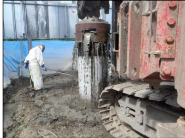
杭汚泥発生状況
