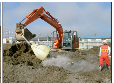
杭汚泥にパルコート散布
