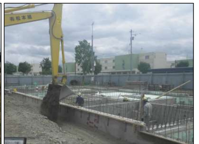
建物周辺へ埋戻 (再生利用)
