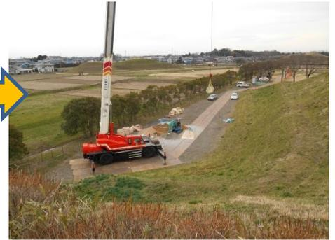
パルコート混合は、古墳の裾野で混合し、大型クレーンにて搬入
